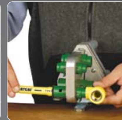
Con una segunda termofusión se unen el tubo y la conexión
