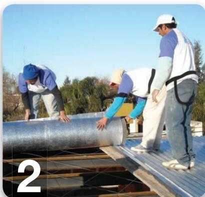
Se presenta el rollo en el mismo sentido que las chapas de la cubierta. Se coloca el segundo rollo paralelo al primero superponiendo los solapes para hacer la unión por termosoldado.
