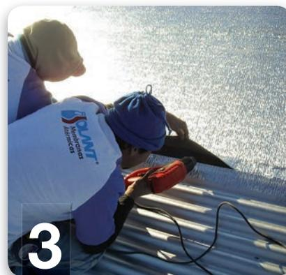
Se puede termosoldar rollo a rollo sobre la estructura.
