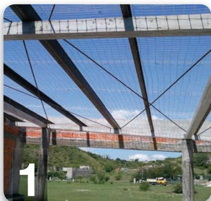
Sobre las correas se prepara un sostén de RED ISOLANT. También puede utilizarse alambre galvanizado haciendo un entramado de 40x40. Esta malla dará a la membrana el soporte necesario para lograr una adecuada terminación, evitando que las uniones se caigan o alabeen.
