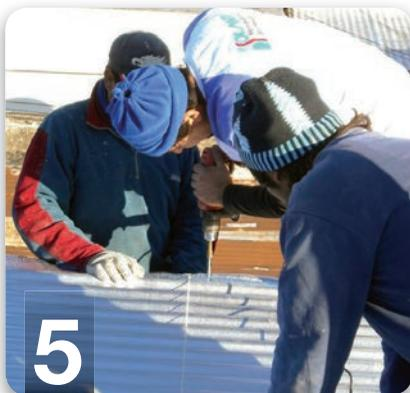
La membrana se fija conjuntamente con la chapa, con tornillos autoperforantes o ganchos. Gracias a la memoria elástica del material la espuma se cierra en el punto de fijación impidiendo el pasaje de agua o vapor.
